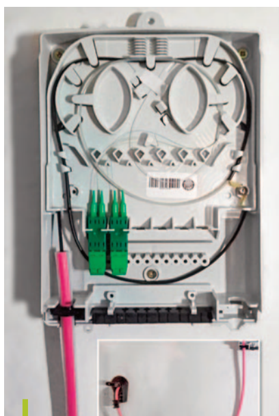
F2X APL mit 4xLC/APC Abschluss und Mikrorohr-Wanddurchführung
